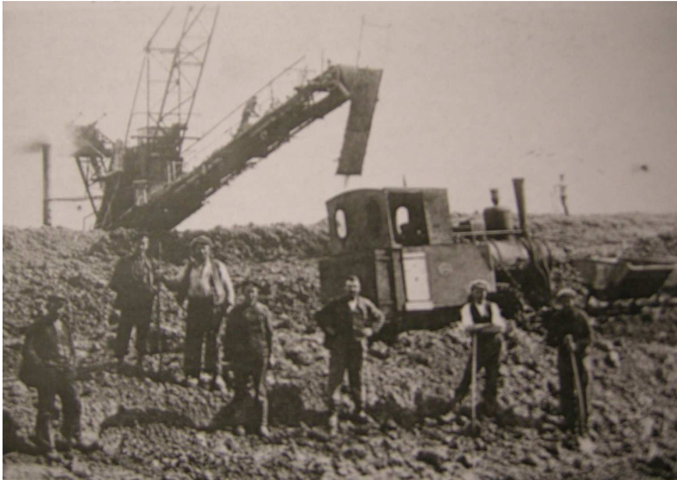
Der arbejdes ved tipvogne lokomotivet og den dampdrevne kran.
